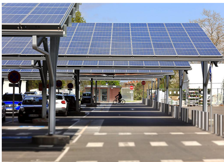
Exemple d'ombrières photovoltaïques sur parking (Source : Banque des territoires)
