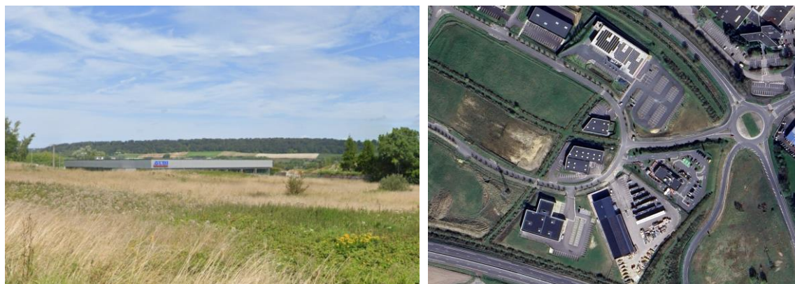
À gauche, la toiture du supermarché ALDI, en contrebas de la pente du Champ-Sainte-Marie a été recouverte de PV. La surface plane du toit et l'insertion du bâtiment dans la topographie rendent l'installation très discrète et à peine perceptible depuis son environnement proche. À droite, une photo aérienne des bâtiments du champ Saint-Marie qui se sont déjà dotés d'installations ENR.
