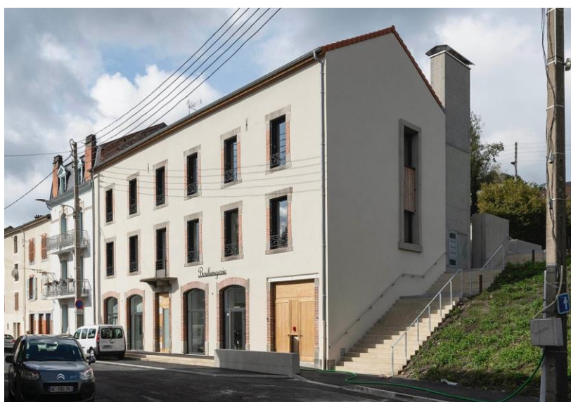
Un autre exemple à La Monnerie le Montel (63) – @ADR Architectes
