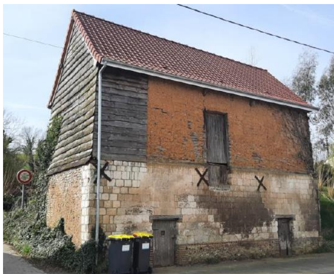
Une grange avec étage à Brimeux. Soubassement en silex, lit en brique, craie taillée, sablière, pan de bois et torchis, bardage bois. Source : inventaire du patrimoine.
