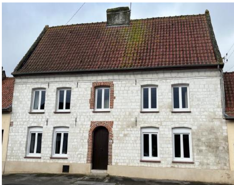
En haut : maison de bourg à Douriez. En bas : maison de bourg à Blangy-sur-Ternoise. Source : inventaire du patrimoine.
