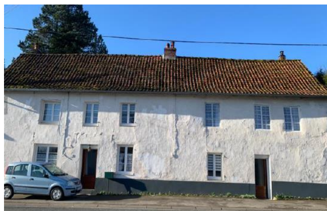
Maison en torchis à étage sur rue à Lespinoy. Source : inventaire du patrimoine.
