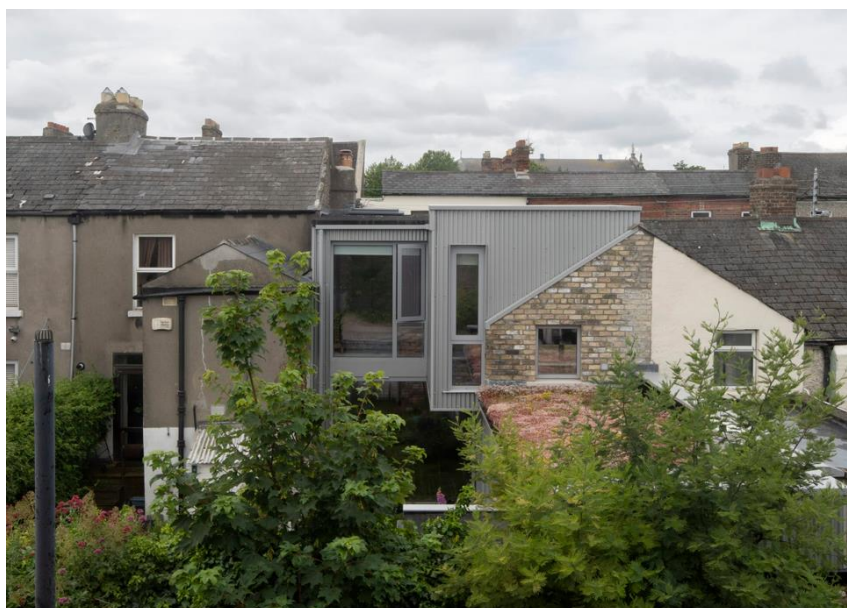
Construction d'une maison mitoyenne dans le tissu ancien des faubourgs de Dublin. @Scullion architectes.
