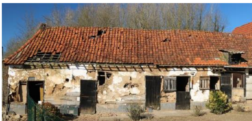
Longère dont l'ossature bois a pu être cimentée à Tortefontaine. Source : inventaire du patrimoine.
