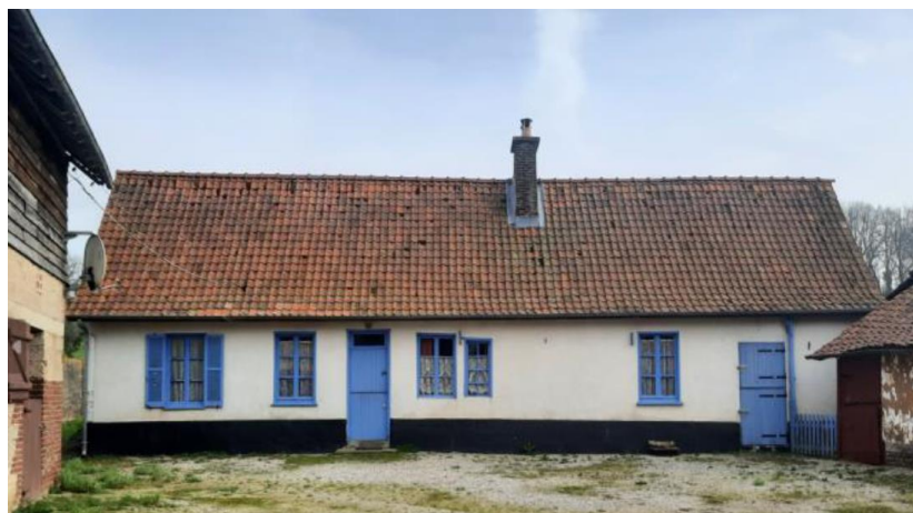
Longère dont l'ossature bois a pu être cimentée à Tortefontaine. Source : inventaire du patrimoine.
