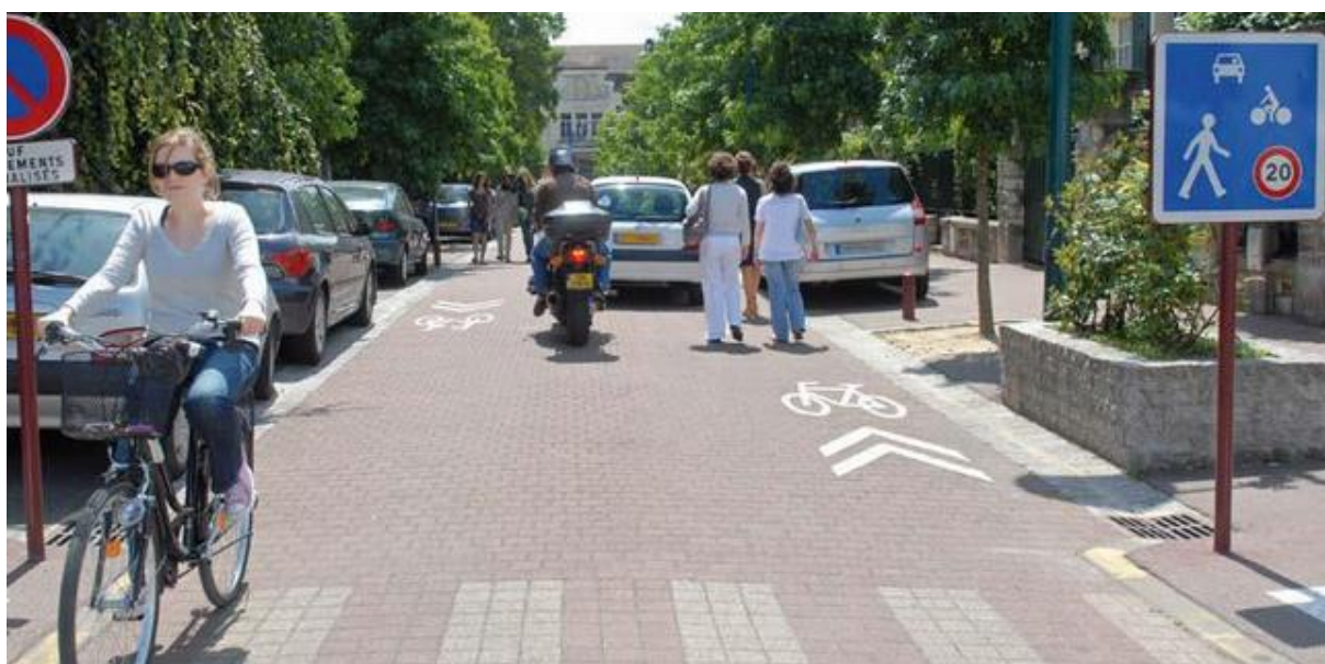
Exemple de zone de rencontre, la trace de la chaussée est estompée, les piétons et vélos sont prioritaires et circulent sur le même espace des véhicules dont la vitesse est limitée à 20 km/h.
