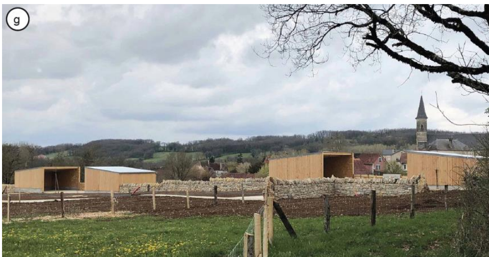
Construction des carports en structure légère avant la livraison du quartier. @Atelier de l'Ourcq
