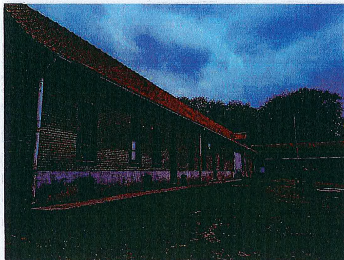
Ancien corps de ferme en bordure de la voie d'accès amont
